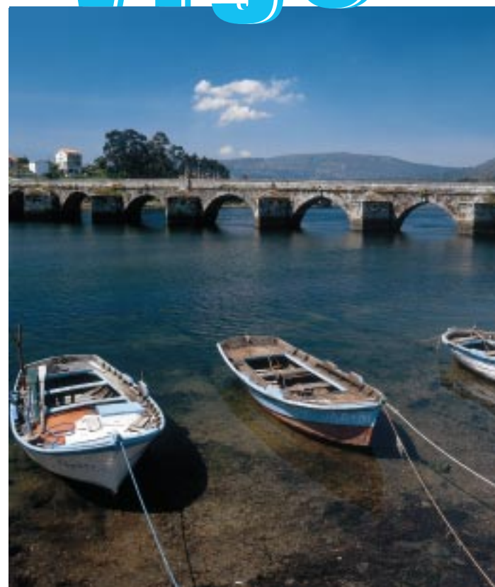
Ponte Sampaio, Pontevedra
