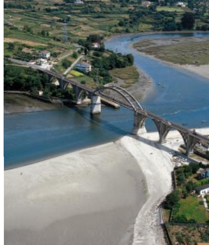
Pedrido bridge, Paderne (A Coruña)
