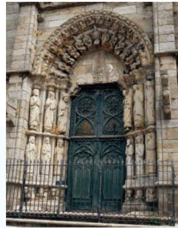
San Martiño church door, Noia (A Coruña)
